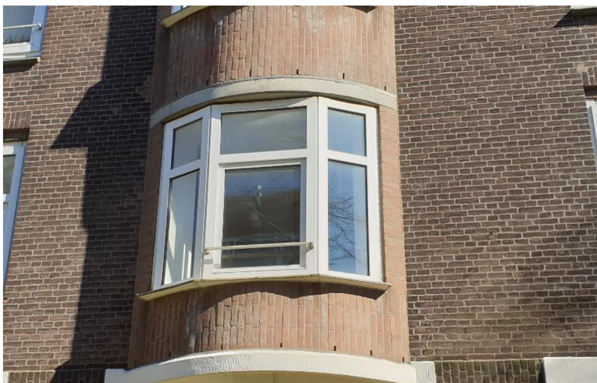
Figuur 9 - Voorbeeld van open stootvoegen in voorgevels van panden in de Frank van Borselenstraat
