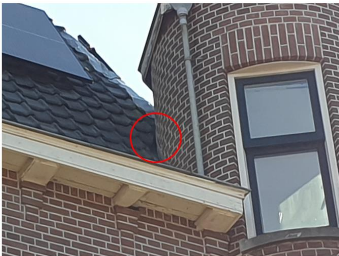
Figuur 7 – opening onder schuin liggende dakpan in Beatrijsstraat. Potentieel geschikte verblijfplaats voor huismus.
